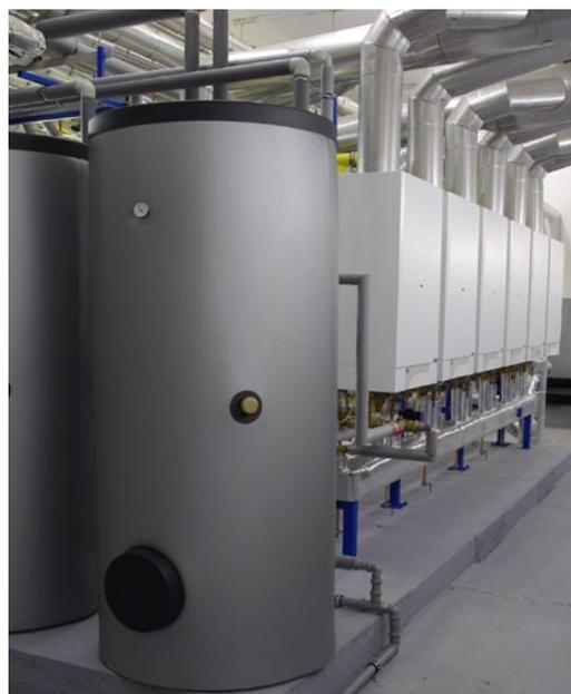
с самой лучшей стороны на рынке отопительной техники. Он широко используется при комплектации каскадных котельных в крупных административных и промышленных объектах с возможностью объединения до 10 котлов в одну систему общей мощностью до 900 кВт. Для уравнивания динамических ударов в каскадном соединении применяются разработанные в компании THERMONA гидравлические выровнители THERMSET. Исполнение TRIO 90 T предусматривает принудительный отвод дыма с помощью вентилятора.
